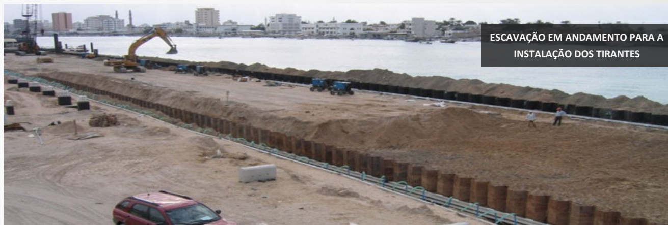
ESTACAS-PRANCHA INSTALADAS PARA O MURO DE ANCORAGEM
