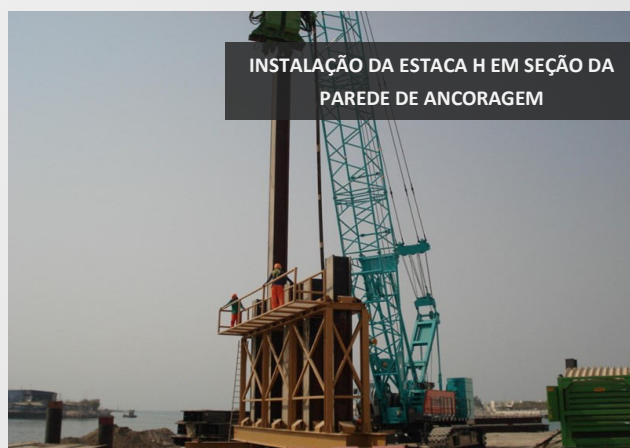
IÇAMENTO DAS ESTACAS NO LOCAL PARA O COMEÇO DA INSTALAÇÃO
