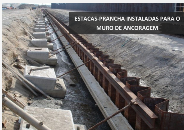
A INSTALAÇÃO ATÉ A PROFUNDIDADE FINAL DAS ESTACAS-PRANCHA É REALIZADA PELO BATE-ESTACA HIDRÁULICO IHC S90
